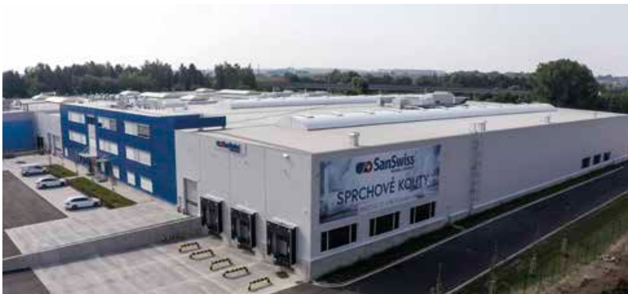
SanSwiss s.r.o., nová multifunkční hala v Jičíně
